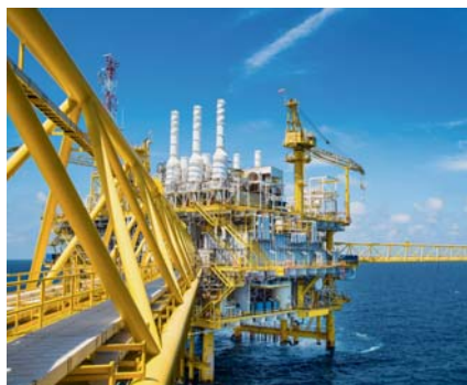
178_ Mehrwert: Offshore-Teile werden via Highspeed-Laserauftragsschweißen beschichtet.
